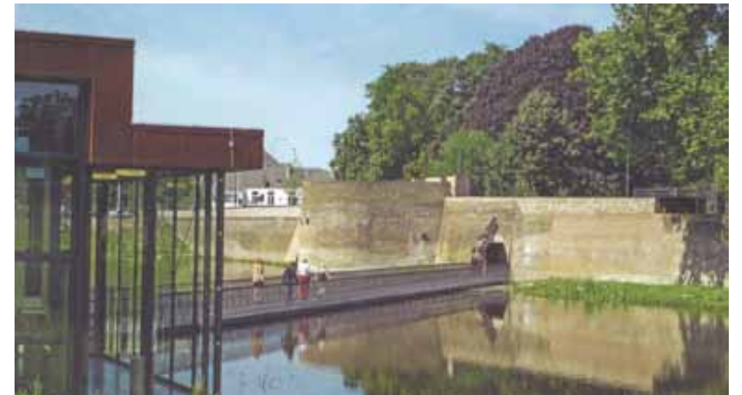
ÅTERSTÄLLD VALLGRAV/KANAL OVANPÅ NYTT PARKERINGSGARAGE, NY ENTRÉ GENOM STADSMUREN
