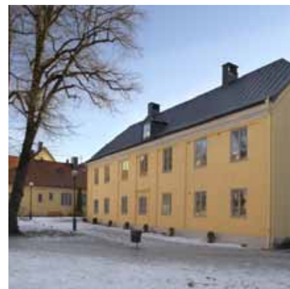
FORTIFIKATIONSHUSET BYGGT 1746-48. RITAT AV BENGT WILHELM CARLBERG
