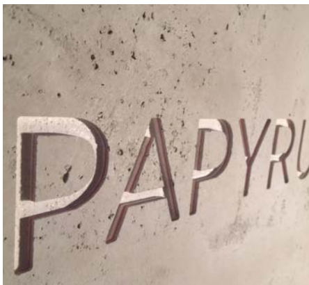
Ytbearbetning på betong
