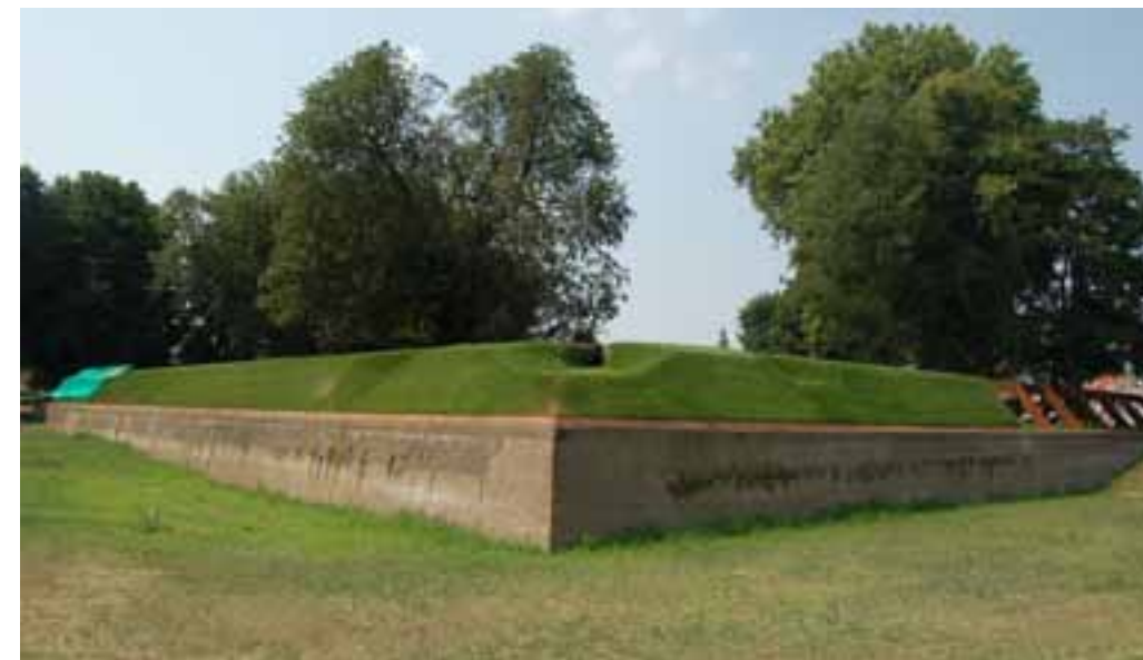
BASTIONEN MED EXAKT REKONSTRUERAD JORDVALL SAMT TILL HÖGER REKONSTRUKTION AV JORDVALLEN SOM EN "BRÖSTKORG" AV CORTENSTÅLPROFILER
