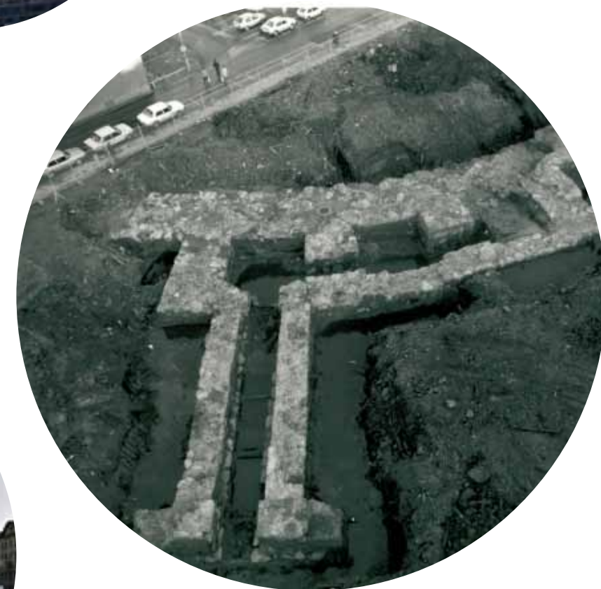
I STADSKÄRNAN LIGGER DE NEDRE DELARNA AV FÄSTNINGSMURARNA SÅ GOTT SOM INTAKTA UNDER MARK. HÄR SYNS EN LITEN DEL AV NORRA FLANKMUREN TILLHÖRANDE BASTIONEN CAROLUS NONUS REX SOM GRÄVDES FRAM UNDER KV SLUSSKVARNEN ÅR 1984. FOTO: LARS NOORD
