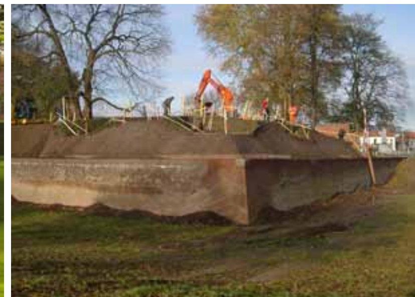
UNDER PÅGÅENDE ARBETE MED VALLEN
