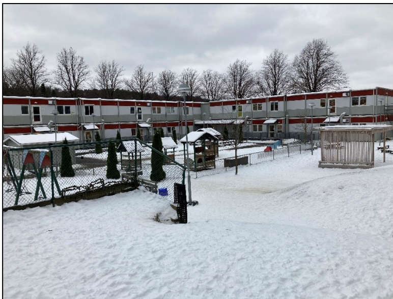
Befintlig tillfällig förskola. Foto: SBK
