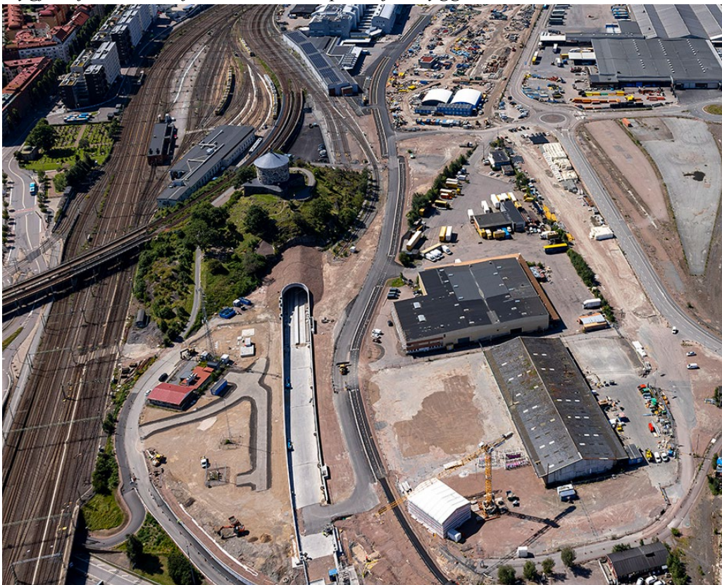
Flygfoto för området från 2024. Efter byggnation. Entreprenaden är ännu inte helt avslutad.
