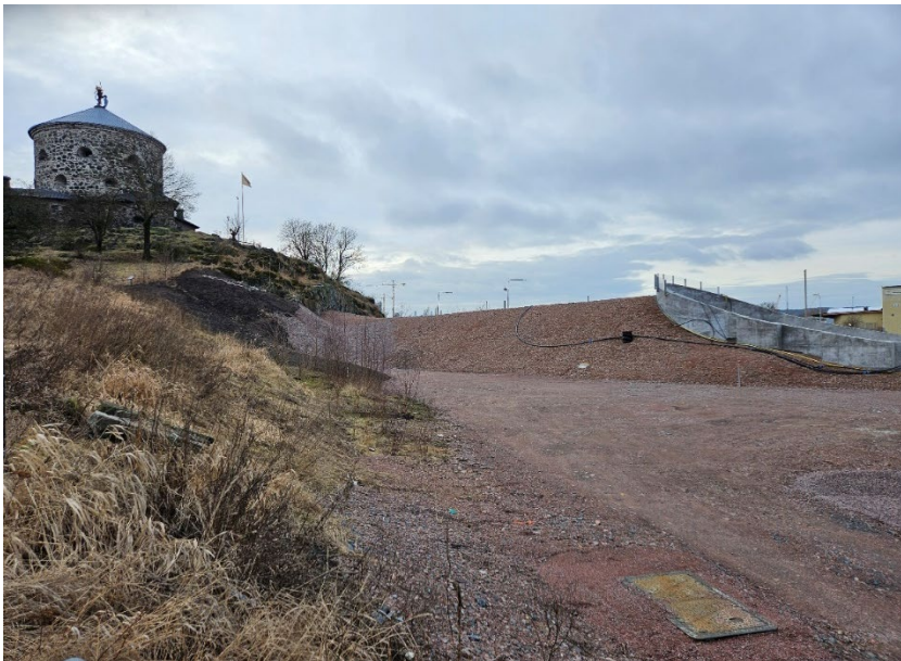
Bild från pågående entreprenad. Foto taget i februari 2025.
