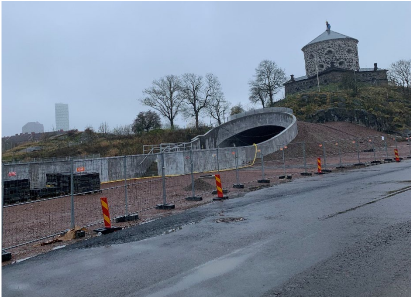
Bild från pågående entreprenad. Foto taget i november 2024.
