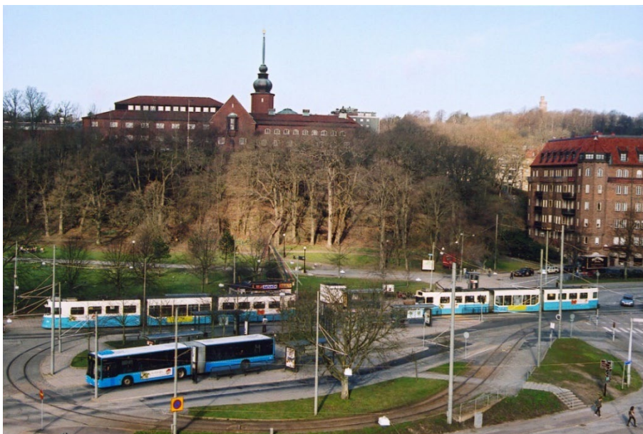
Figur 54 Dagens spårvagnshållplats, med tillhörande vändslinga.
