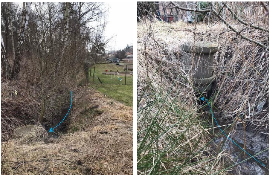
Norra delen av diket. Foto: Kretslopp och vatten.
