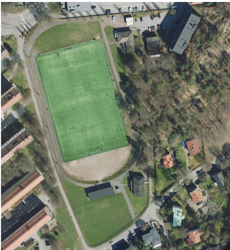
Figur 13. Ortofoto över Överåsullen och tillhörande byggnader.
