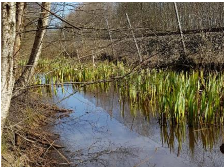
Bäck/dike längs spårvägen (Foto: Sweco)
