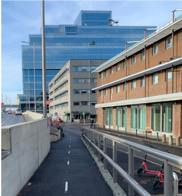
Figur 29: Foto visar den stödmur som finns mellan Mårten Krakowgatan och hur nivåskillnaderna skiljer sig åt mellan stödmuren, Gång- och cykelvägen och Kilsgatan.
