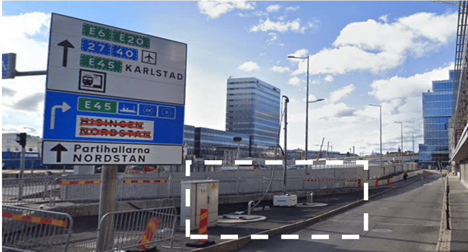
Figur 48: Bild visar befintlig spillvattenpumpstation vid Kilsgatan.
