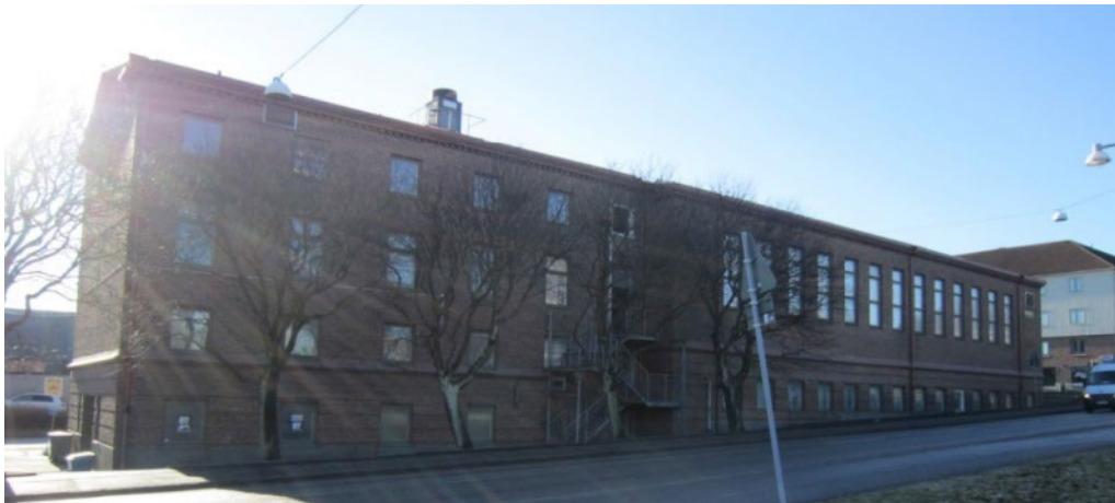
GS-hallen, fasad sedd från Karl-Johansgatan, vid takfoten skymtas tandsnitten som fortsätter runt byggnaden. Foto Sara Holényi.
