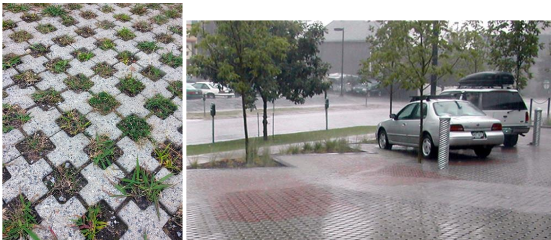
Figur 21 Exempel på parkering med genomsläpplig beläggning (VASYD, 2019) (Svensk byggtjänst, 2012)
