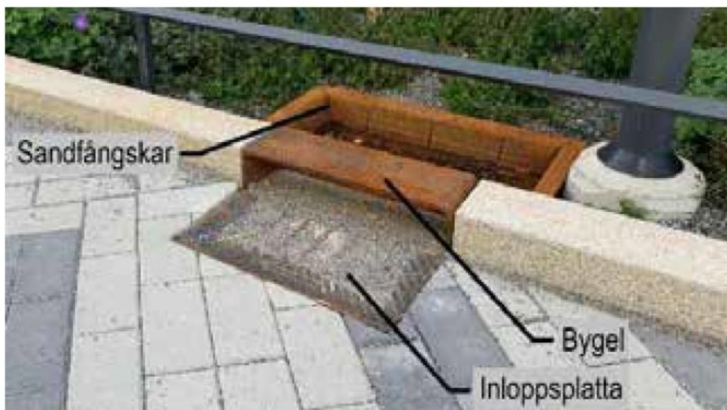
Figur 16. Principlösning för inlopp till regnbäddar. 2
