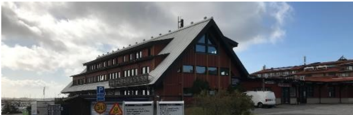
Befintlig verksamhetsbyggnad inom fastigheten.
