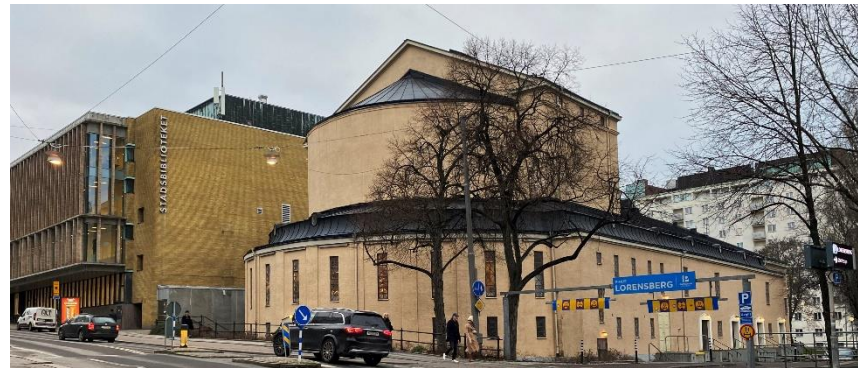
Fotot visar Stadsbiblioteket, baksidan av Lorensbergsteatern och i bakgrunden skymtas Park Avenue Hotel. Fasadmaterialen i varma kulörer samspelar med varandra. Av bilden framkommer även bebyggelsens i övrigt varierade arkitektur.
