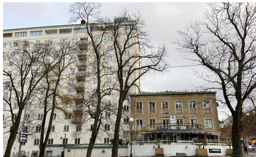
Park Avenue Hotel med sin höga respektive låga byggnadskropp.
