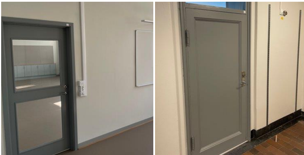
Rumsbildning mellan klassrum och befintliga partier som restaurerats
