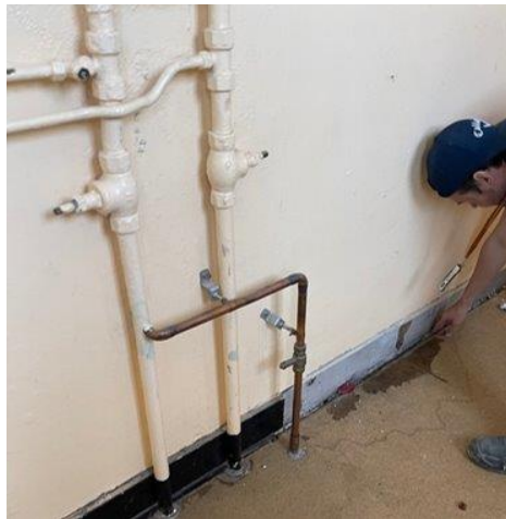
Befintliga partier samt en vattenläcka hittad på plats
