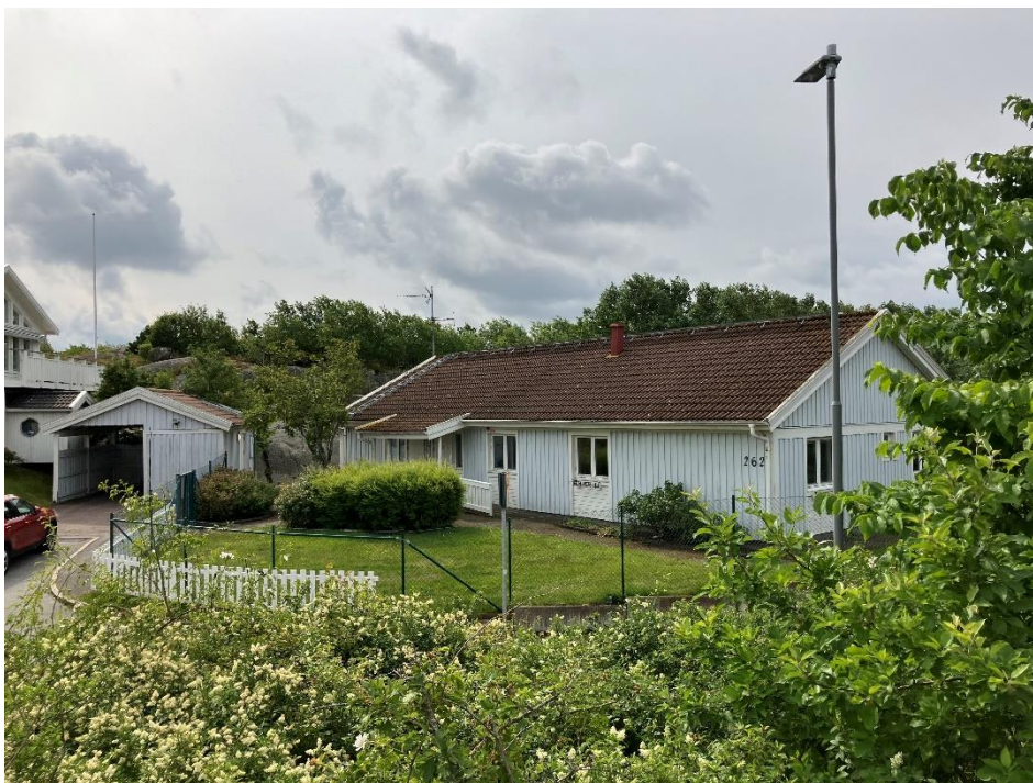
Figur 5. Fastigheten med befintlig byggnad sett från Södra Fiskebäcksvägen.
