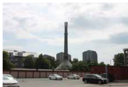
Bild: Före detta panncentralen, Tratten
