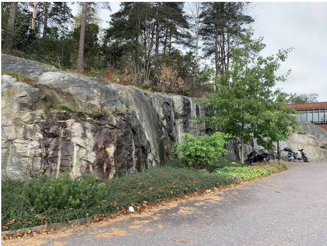
Figur 3.1.3 Sprängd bergskärning. Vy mot norr
