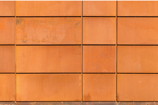
PRIMOHUSET 3 våningar Fasad av Cor-tenplåt
