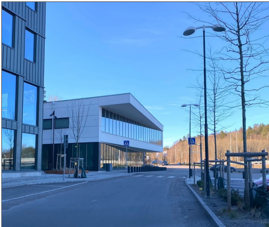
Figur 7. Lomarhuset med vitt skivmaterial och stora glasade ytor mot väg 158 Säröleden. Bilden är tagen från gatan Björklundabacken mot norr. Längst till vänster skimtar byggnaden som inrymmer bland annat Noblaskolan.
