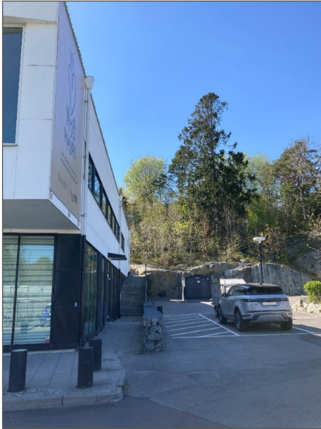
Figur 8. Lomarhusets norra fasad med en av dess entréer med skärmtak. I mitten av fotografiet, inklädd mot berget, syns den grå transformatorstationen.
