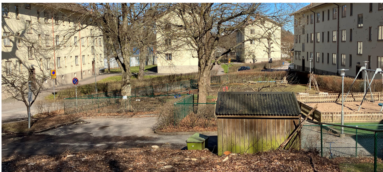
BILD FRÅN LILLÄNGSGATAN INNAN RENOVERING. FOTO: KAJSA FROSTENSSON.
