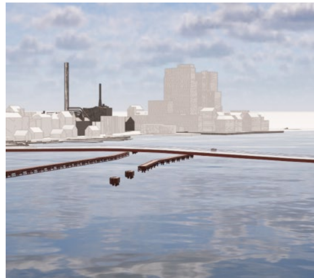
Gång- och cykelbron med vy ovanför Frihamnspirens yttersta punkt
