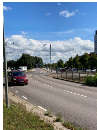
Backaplan omges av kraftiga trafikbarriärer. Bilden visar Hjalmar Brantingsgatan i söder.
