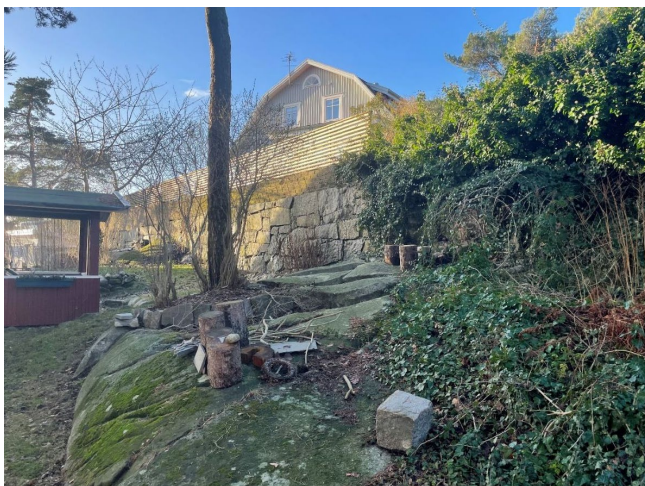
Figur 14. Bergsslänt i väster, Geoteknisk Beskrivning figur 2
