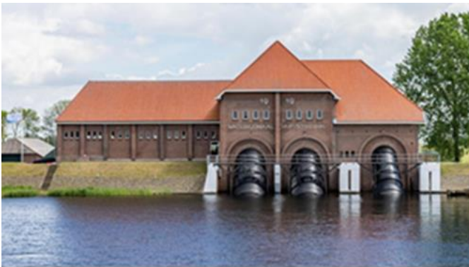
Figur 5. Exempel på äldre modell av pumpstation t.v. (A.F. Stroink) samt nyare skyddsport och pumpstation i nederländska Schardam med kapacitet på 2000 m 3 /min (där Sweco utformat pumpstationen).
