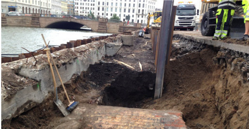
Bild: Kanalmursrenovering Norra Hamngatan, Foto: Vårt Göteborg
