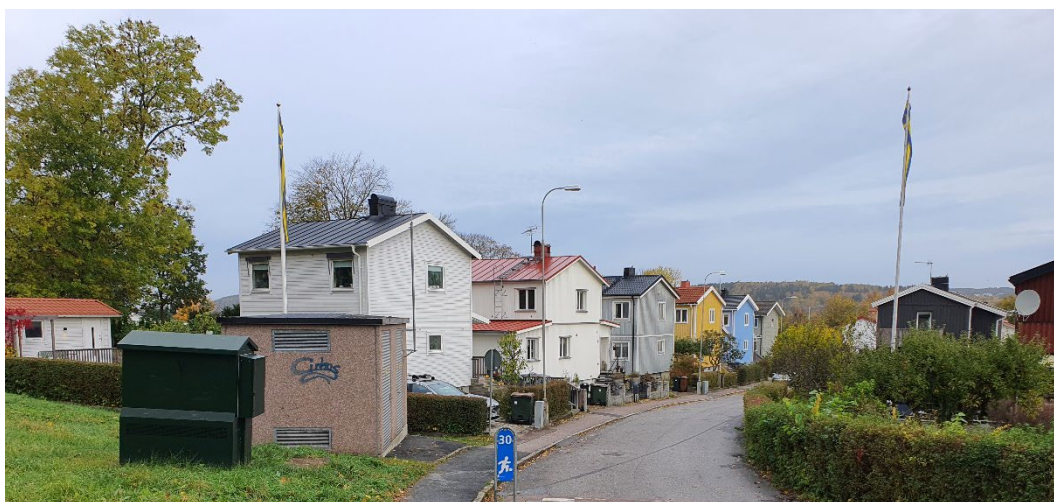
Egnahemsbebyggelse längs med Hembyggarevägen.
