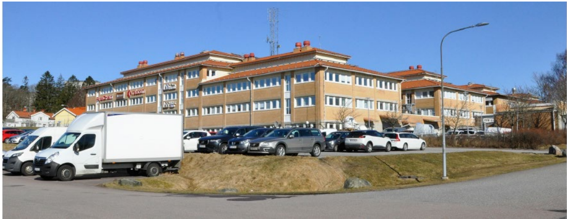
Figur 17. Kontorsbyggnaden söder om Radiovägen, uppförd på 1990-talet som en stor sammanhängande volym. Källa: kulturmiljöutredningen (Antiquum, 2018-08-29).
