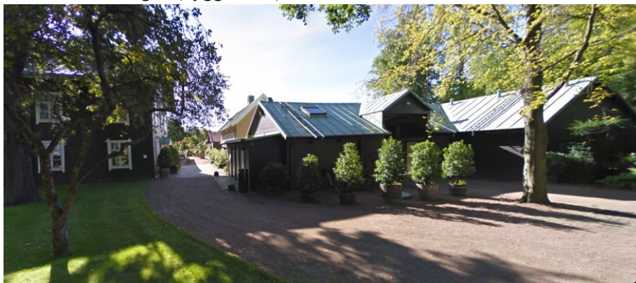
Till vänster Frömagasinet, gult hus i mitten Elevbostaden, till höger förråden runt arbetsgården, Google maps
