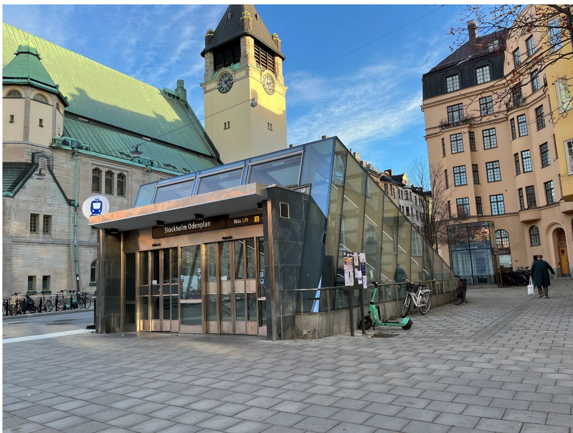
Figur 27. Exempel på utformning av huskonstruktion ovan mark vid uppgång från underjordisk hållplats i Stockholm. Foto: AFRY.
