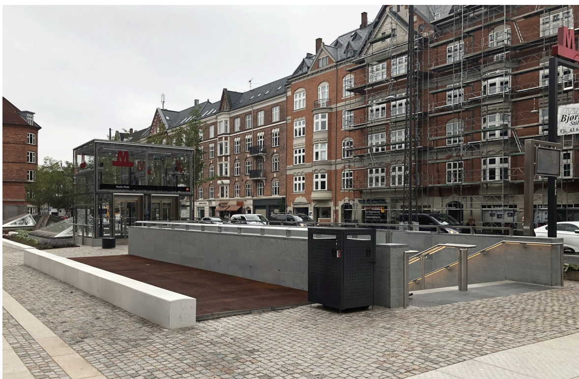
Figur 28. Exempel på entré i Köpenhamn med vertikallissar och vanliga trappor till ett mellanplan direkt under marknivå. Fotografi: AFRY.
