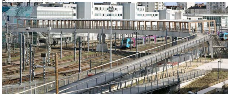
Gång- och cykelbro över bangården i Angers
