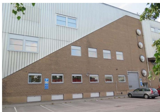
Den östra långsidans parti med diagonal gräns mellan plåt- och tegelfasad.
