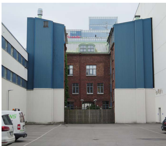
Gårdsfasaderna mot den obebyggda tomten åt öster.
