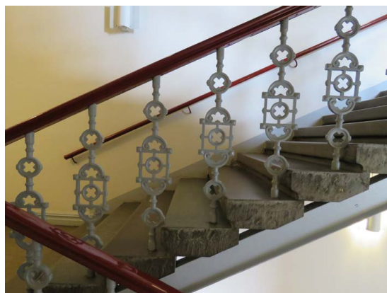
Trappa med dekorerat mitträcke i gjutjärn, handledare i trä och plansteg i natursten vilande på järnbalkar.
