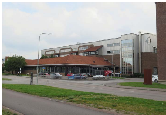
Fabriksanläggningen sett från nordväst med den lägre delen för personalutrymmen närmast i bild.
