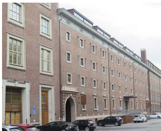
Byggnaden på Kämpegatan 6 (i mitten) med karaktärsstarka fasader i rött tegel med naturstensdetaljer.
