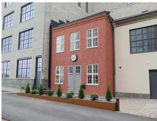
Den småskaliga, enkelt utformade före detta transformatorstationen mot det östra av kvarterets två gårdsrum.
