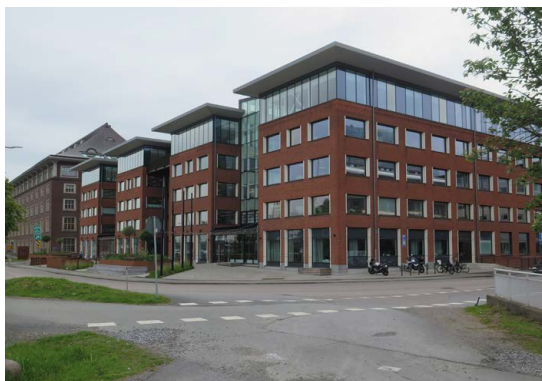
1980-talshuset ut mot älven med "Pagoden" till vänster.
