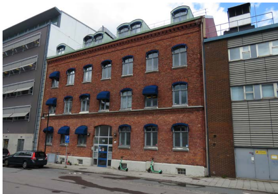
Gatufasader för byggnaden på Kilsgatan 10.
