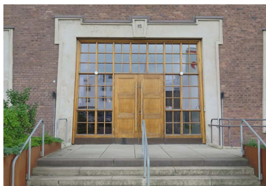
"Pagodens" huvudentré med ekport med markanta sidor och överljus och omfattningar i obehandlad betong.
