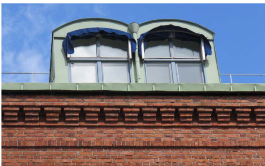
Byggnadens mönstermurade takfot med bland annat tandsnitt. Ovan de två sentida tillkomna takkuporna i par.
