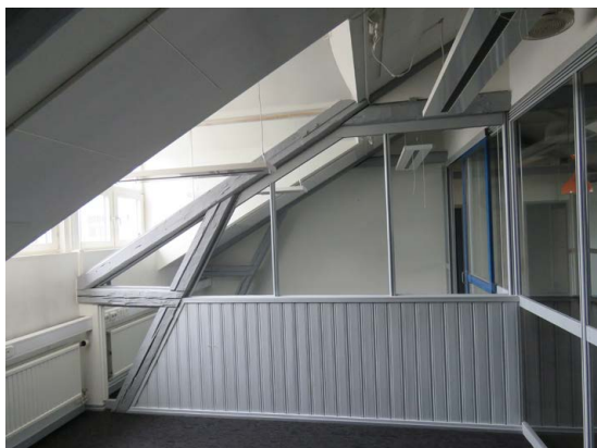
Rumsavskiljande glasväggar med bröstning av pärl-spontspanel infällda i takstolen.
