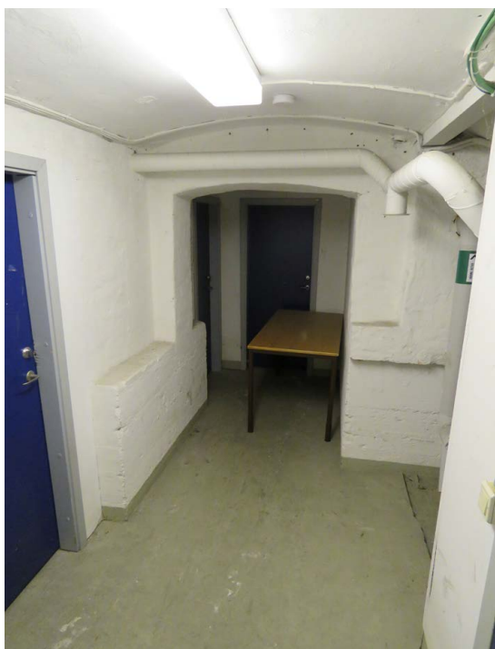
Sydöstra trapphusets källarplan med flacka, tunnvalvsslagna tak.
