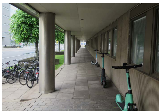
Mot söder finns en arkadgång med pelare i blank metall. Utanpå löper en trädrad mellan gången och gatan.
