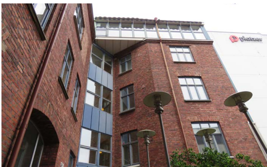
Gårdssidans norra flygel med sentida inbyggt hörn och fönsterraden i det kraftigt lyfta takfallet.
