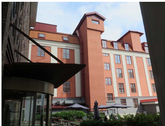
Byggnadslängan mot Torsgatan sett från gården med de varma fasaderna och det utanpåliggande hisstornet.
