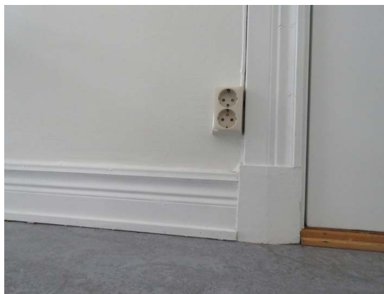
Äldre profilerad golvlist samt dörrfoder i kontorsutrymmet.
