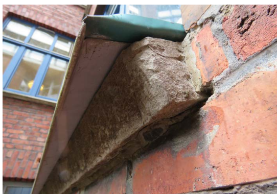
Ovan: dropplista på innergården där kalksten syns under plåten. Flertalet övriga dropplister är helt inklädda i plåt.
