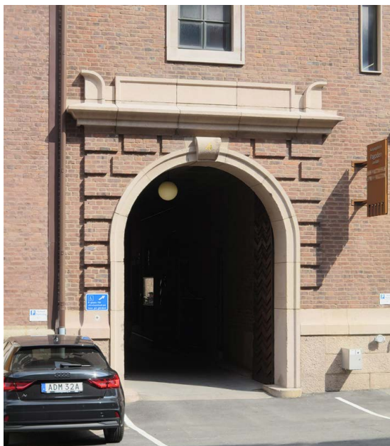
Detalj över en port med många av de dekorativa inslag som bebyggelsen mot Kämpegatan innehåller; sockel och omfattningar i natursten samt rusticerad murning.
