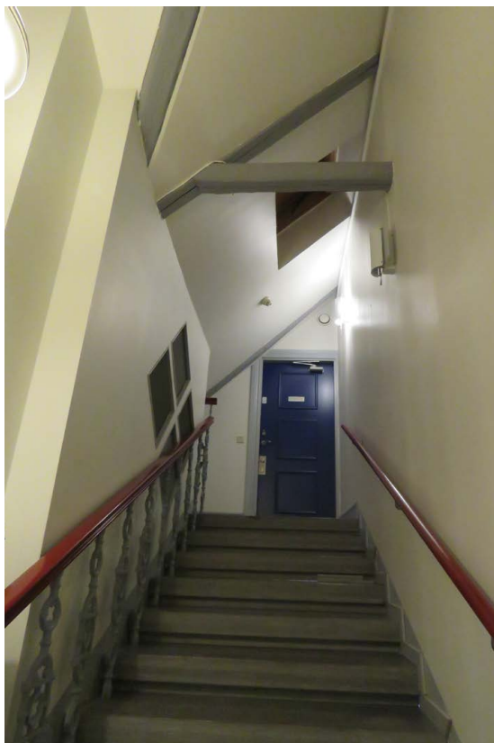
Synliga delar av takstolen i det sydöstra trapphuset.
