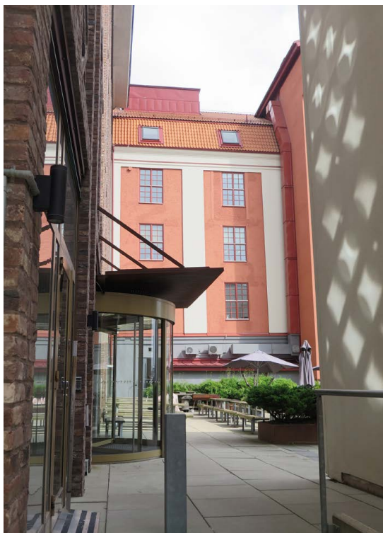
Det östra gårdsrummet får mycket av sin karaktär av de äldre putsade industribyggnaderna med fasader mot denna gård. Foto taget från den smala passagen mellan gårdarna.
