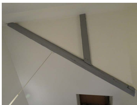
Synliga delar av takstolen i det nordvästra trapphuset.
