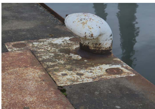
En pollare med tillhörande skyddsplåt från 1930-talet. Närmast älven utgörs kajen av rå betong.
