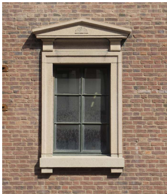
Klassicerande fönsteromfattning i ljus natursten i bottenvåningen på byggnaden på Kämpegatan 6. Övriga byggnader längs gatan har liknande omfattningar.
