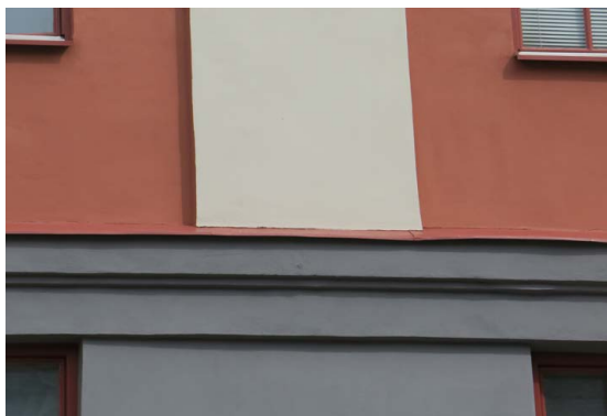
Detaljbild på mötet mellan de olika putsfälten som finns på byggnaderna mot Torsgatan.
