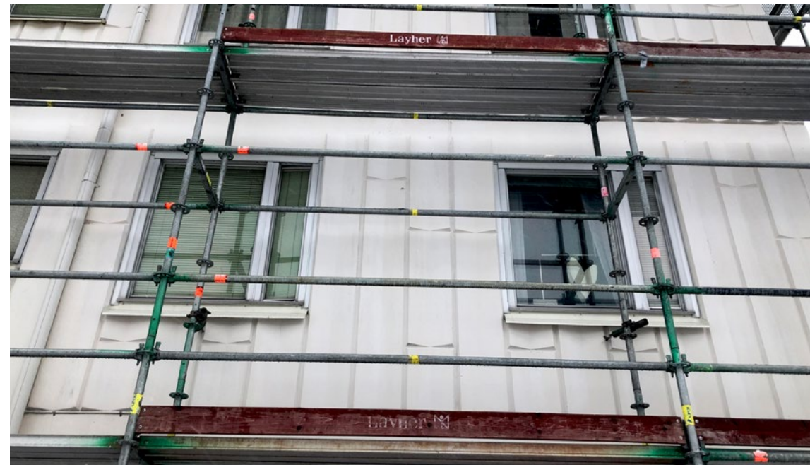
Renovering av fasadelement. Foto: Lars Jonsson.
