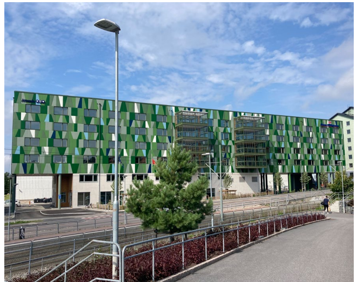
Nybyggnation av äldreboende. Foto: Vanja Larberg
