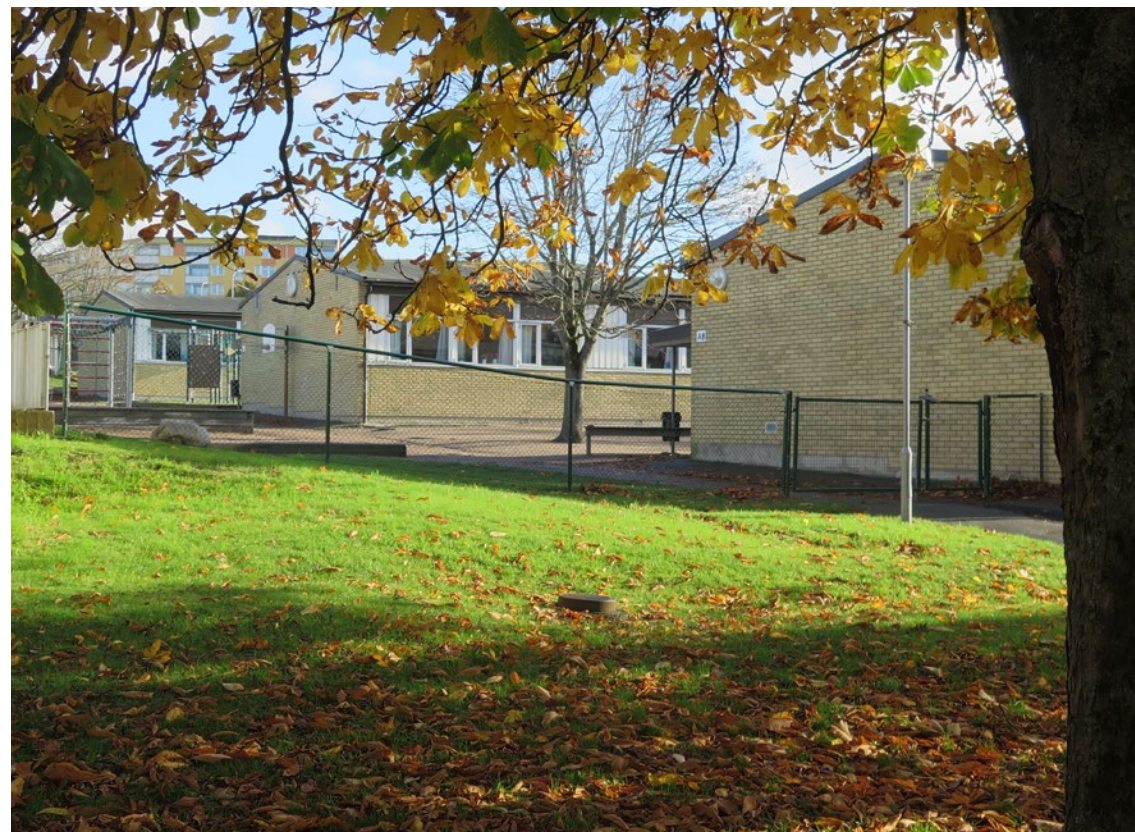
Vättedalsskolan präglas tydligt av den totala funktionsuppdelning som finns mellan olika byggnader. Ut mot spårvägen i söder ligger de tre lågstadiebyggnaderna med separata klassrumsentréer på rad.
