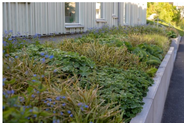
Figur 16 Exempel på regnrabatt/biobädd vid Sannerviksgatan norr om planområdet. Foto: Lina Ekholm
