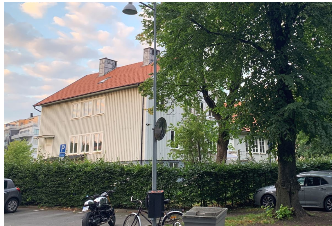
Foto från sydväst, befintlig byggnad
