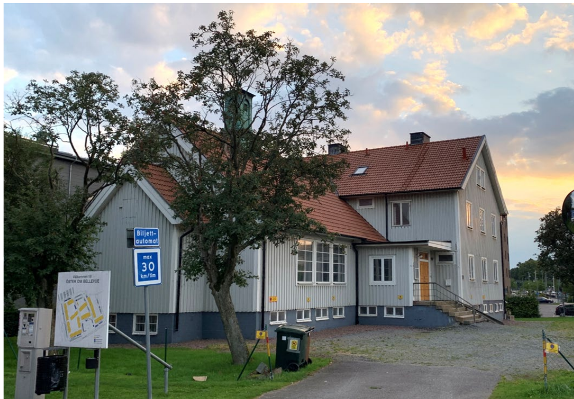
Foto från nordöst, befintlig byggnad
