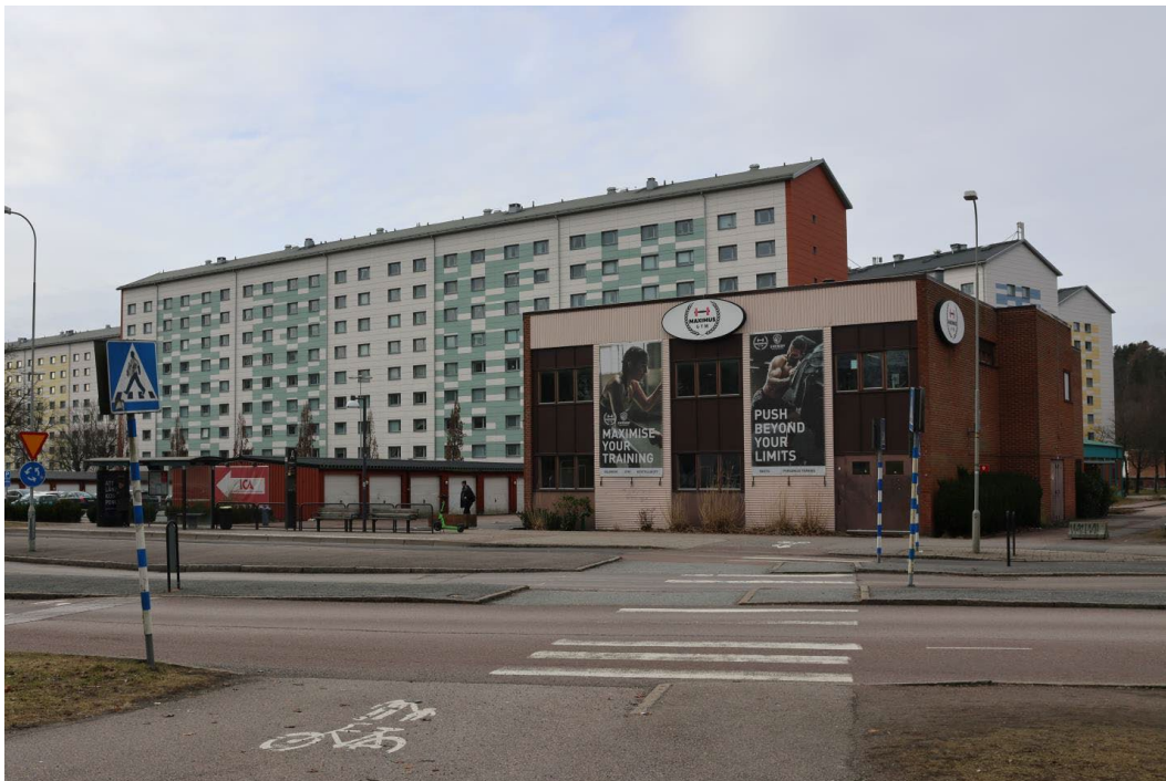
Figur 17 Bild på F d panncentralen. (Lindholm Restaurering AB, 2025)
