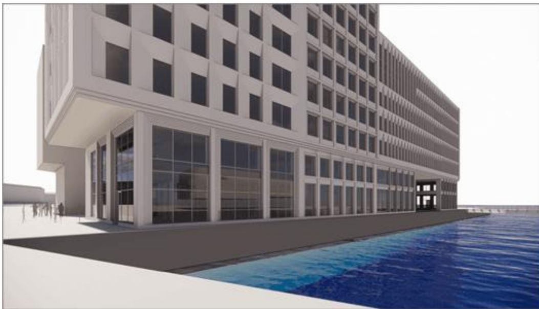
Figur 14: Kvarter A3 med 25-30 cm utkragande dekorfasad på långsidan mot vattnet. Det större överhänget på byggnadens kortsida finns med i gällande plan. Bilden visar inte tänkta material. Byggnadens källarmur utgör halvöns kajkant. Källarmuren kan komma att kläs in med ytskikt för kaj inom vattenområdet. Arkitekterna Krook och Tjäder för Global Business Gate.
