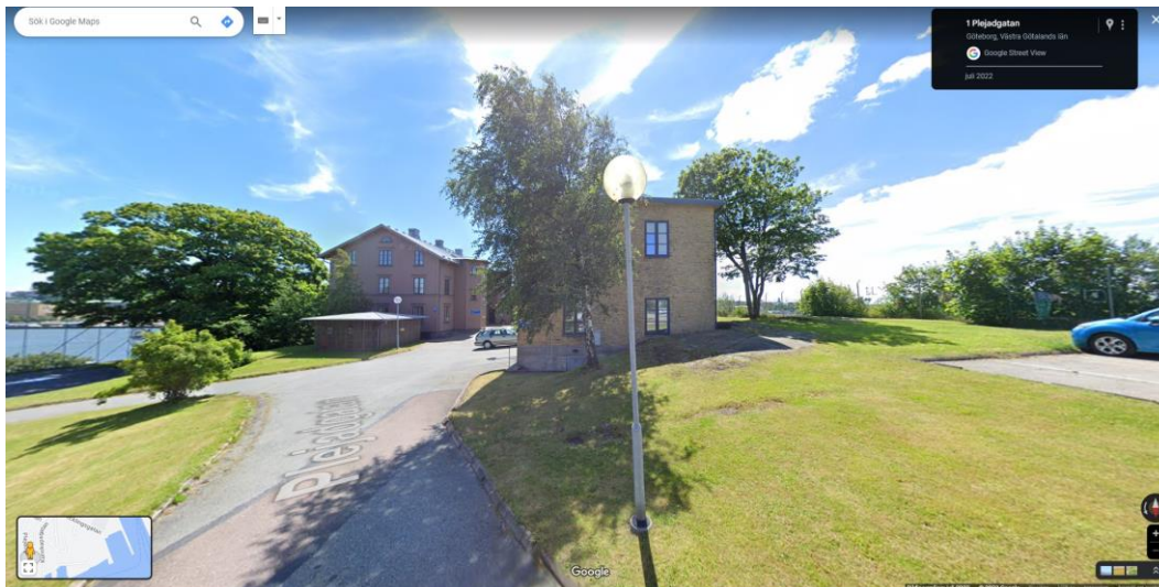
Bild från googlemaps tagen vid slutet av Plejadgatan. Gasverksbyggnaden till höger Disponentvillan till väster. Föreslagen bebyggelse avses uppföras i 4,5 våningar och placeras till höger om, framför samt bakom gasverksbyggnaden.
