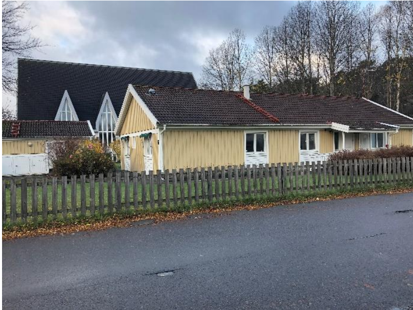
Figur 5. Befintlig byggnad och komplementbyggnad inom planområdet.
