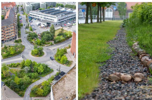
Bild: Till vänster: Bryggervangen och Skt. Kjelds Plads i Köpenhamn. Multifunktionell yta för dagvatten- och skyfallshantering: Bildkälla: (SLA, 2022) från Kretslopp och Vatten. Till höger: Dagvattenhantering i form av makadamdike i Mariastaden. Foto Lina Ekholm, Kretslopp och Vatten.
