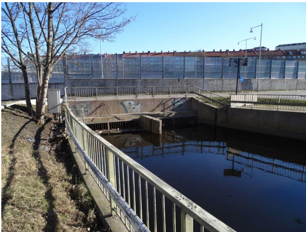
Långa Gullbergskulverten, vy från sydväst, 2015.
