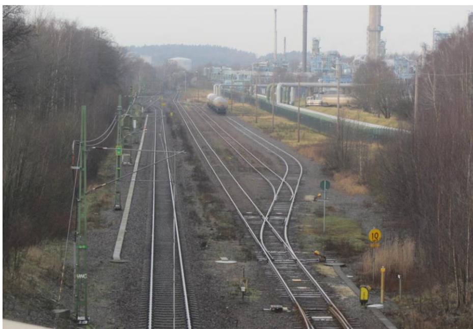
Figur 8 Hamnbanans spår till vänster i bild. Hökebangården till höger. Vy från Ivarsbergsmotet och västerut. Bilden tagen innan utbyggnad av Hamnbanan till dubbelspår.
