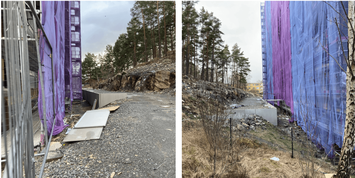
Figur 2: Bergslänt väster om flerbostadshuset. Foto: Göteborgs Stad
