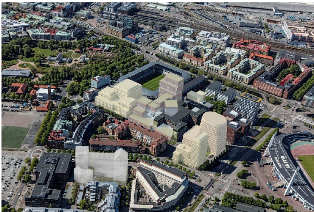
Översiktsfoto 1: Visar helt färdigutbyggd detaljplan med nya byggnader efter att VA-ledningar, dagvattenmagasin, skyfallsled och spillvattenpumpstation byggs för att försörja dessa.
