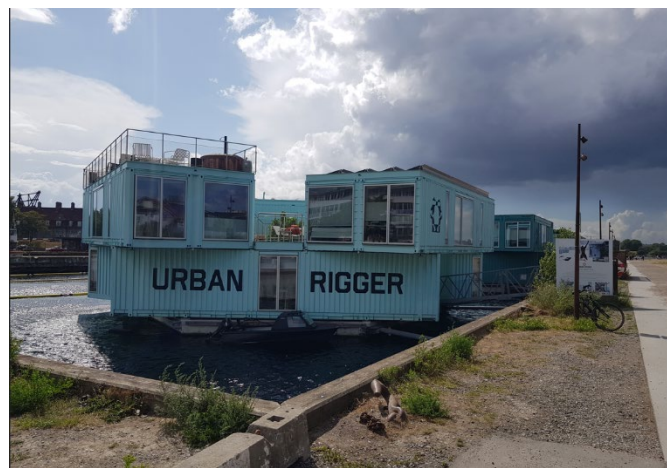
Urban Rigger, Köpenhamn. BIG Architects. Bild: Carl-Johan Schultze
