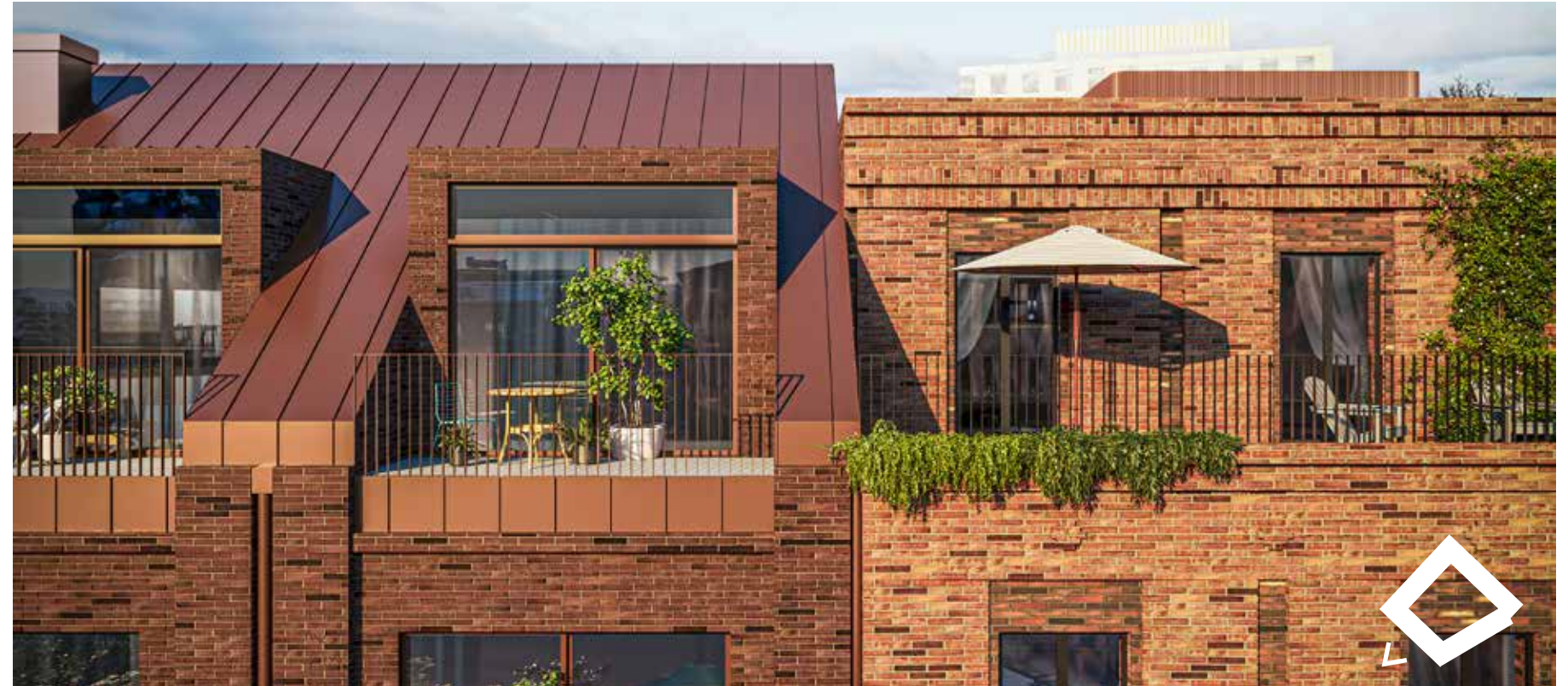
Taklandskapet varierar mellan sadeltak och platta tak. Mötet mellan tak och fasad illustreras med kornisch/gesims.
