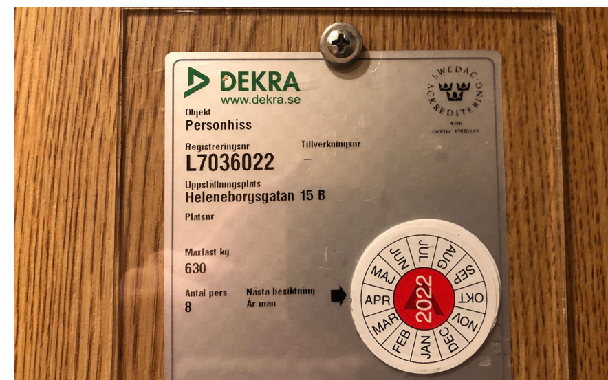
Foto på skylt som finns i hissar som visar när nästa besiktning ska genomföras. Skylten indikerar om hissen är godkänd att använda eller inte.
