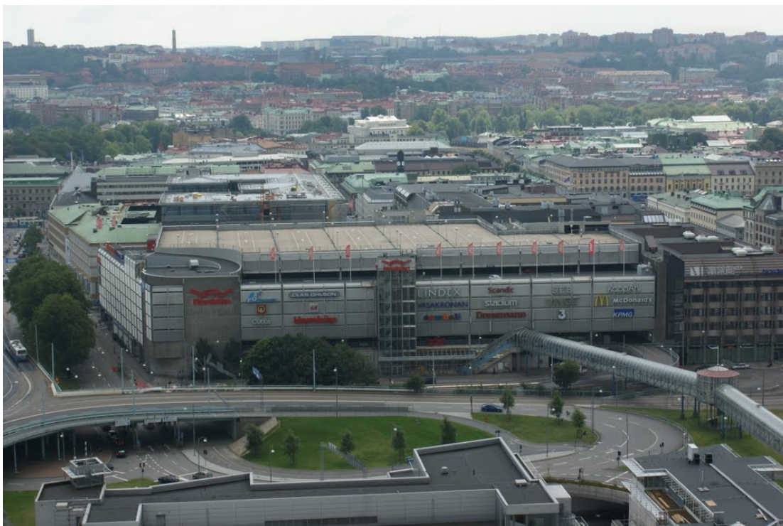
Befintlig miljö inom planområdet, sett från norr.
