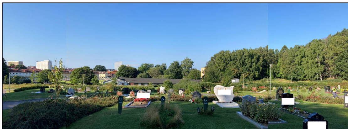
Befintlig förskola, sett från norr.
