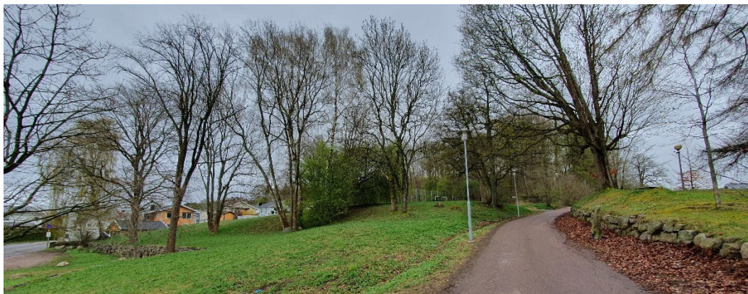
Figur 9 Till vänster i bild syns planområdet och den kallmurade stödmuren. Till höger i bild syns stödmuren som löper längs med gång- och cykelvägen som är en äldre väg,
