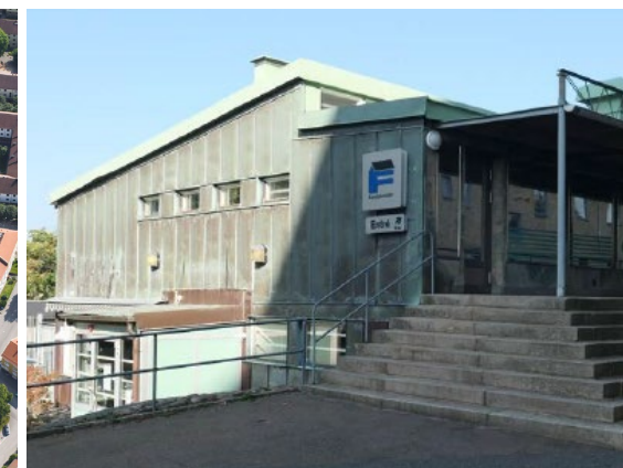
Befintlig byggnad på platsen (fd butikslänga)
