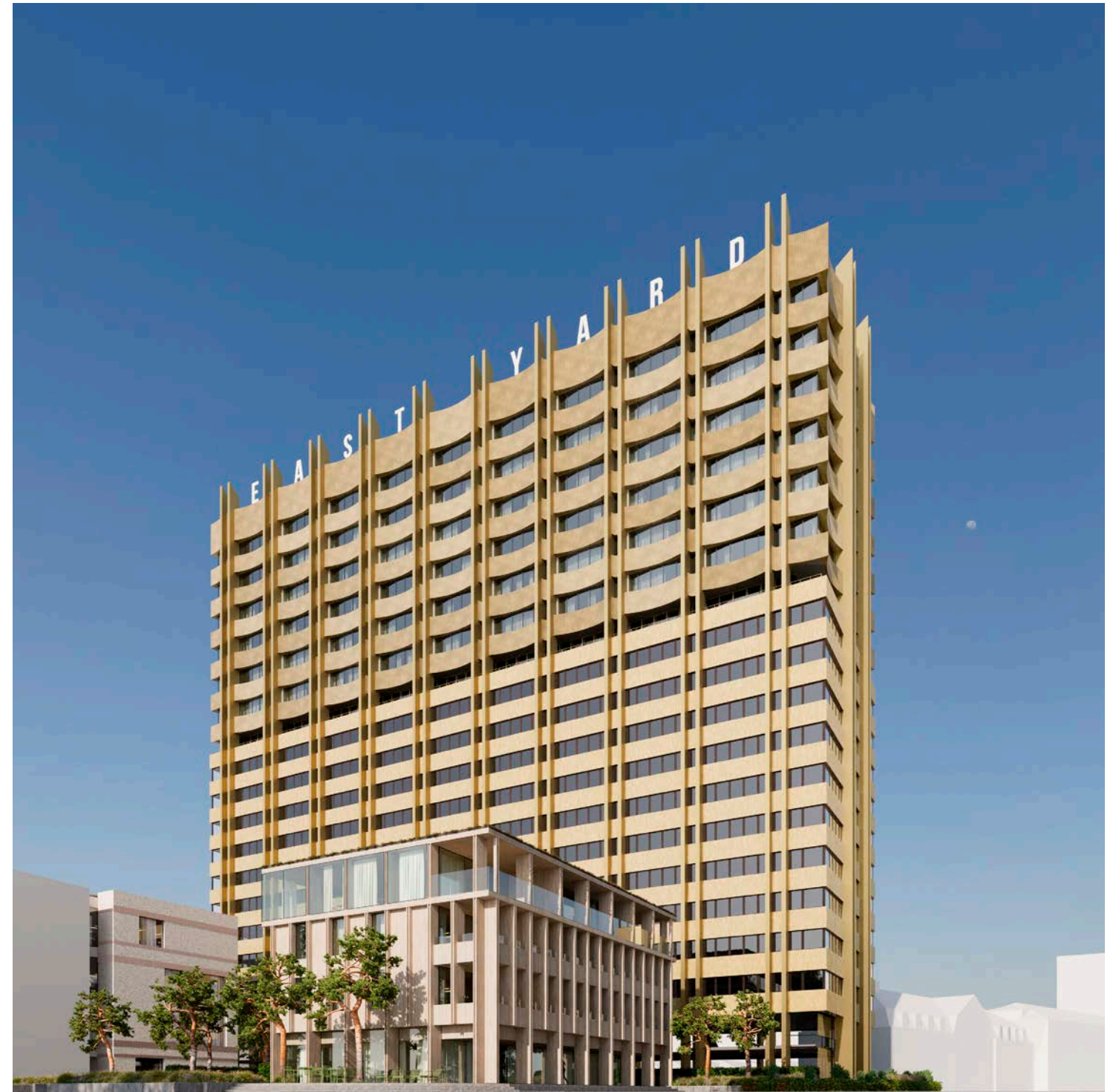
Skylt på långsidorna av byggnadens krona.
