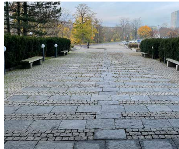
Mönsterläggning av Fjäråsgnejs och smågatsten framför huvudentrée
