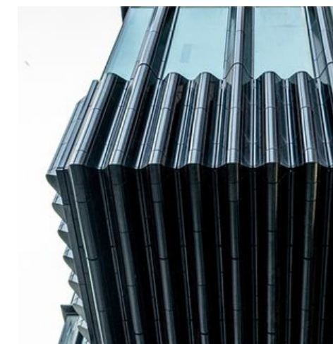
Material från påbyggnad sveper runt och blir undertak för terrass.
